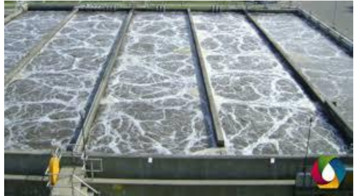
Tanque de aireación
