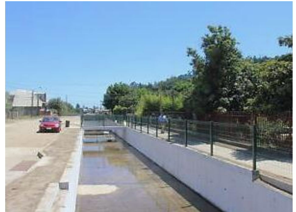
Canal de hormigón
