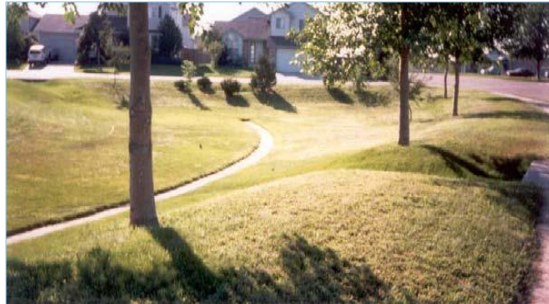
Estanque de regulación en parque
