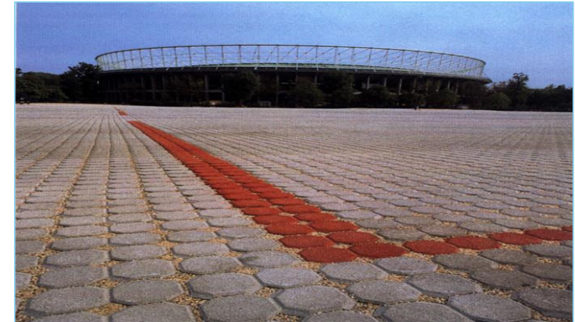
Pavimento celular de adoquines
